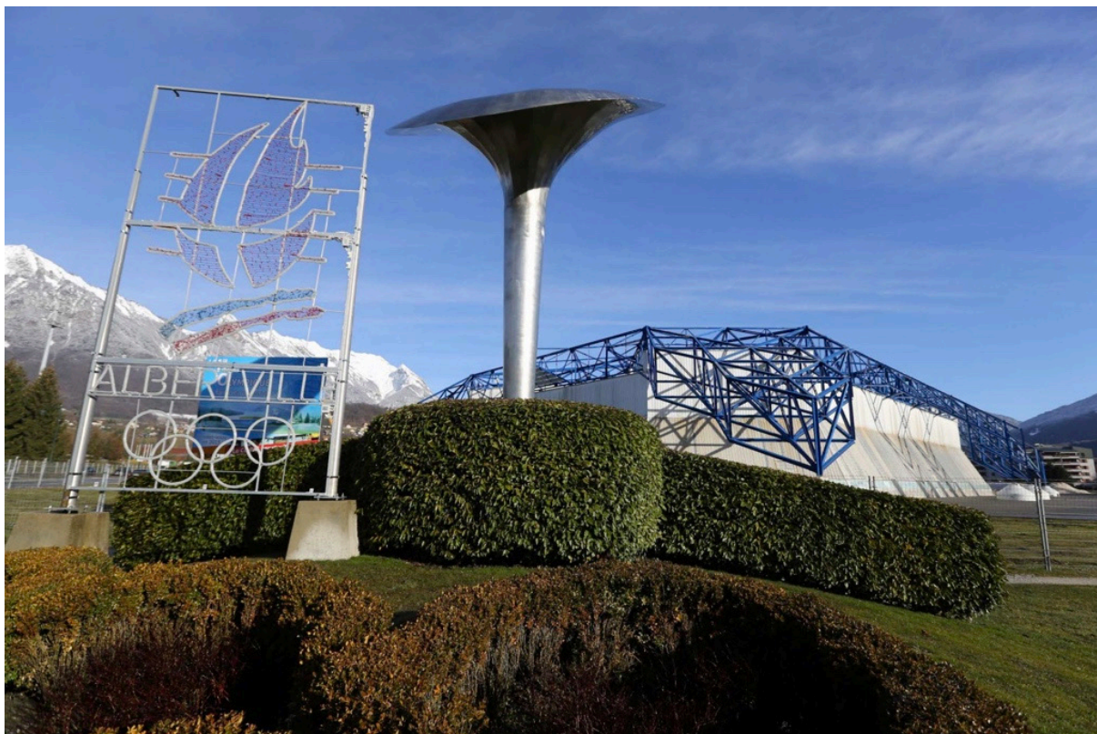
La Halle Olympique d'Albertville
